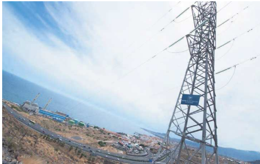
EL NUEVO TENDIDO AÉREO DE 220 Kv SALDRÁ DE LA SUBESTACIÓN QUE SE CONSTRUIRÁ EN LAS CALETILLAS, JUNTO A LA TF-1. DA
